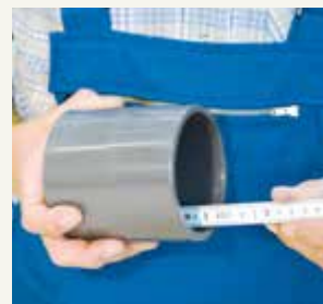
4. Die volle Rohreinstecktiefe ausmessen.
