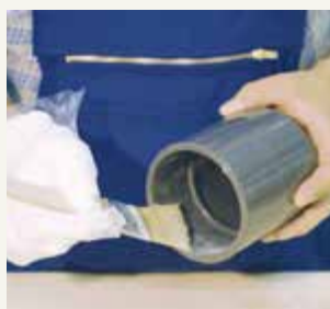
10. Klebstoff umrühren und den Pinsel reichlich mit Klebstoff tränken. Die Fittinginnenseite von innen nach außen in Längsrichtung (axial) relativ dünn einstreichen.
