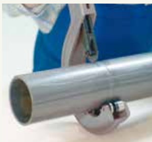
1. Röhre rechtwinklig abtrennen. Benutzen Sie ein Rohrschneidegerät oder eine Säge
