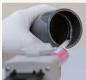
6. Klebstoff auf der Fittinginnenseite auftragen.
