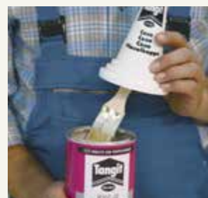
8. Um das Eintrocknen zu verhindern, Dosen in den Klebepausen mit der Tangit Pinselkappe verschließen.
