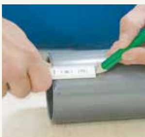
5. Das Maß auf dem Rohrende markieren.
