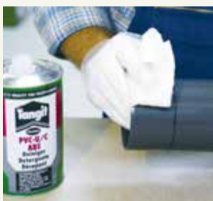
9. Die trockenen Rohrenden außen und die Fittings innen sorgfältig reinigen. Vor dem Klebstoffauftrag müssen die Klebeflächen völlig trocken sein.
