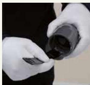
7. Klebstoff auf der Fittinginnenseite von innen nach außen in Längsrichtung (axial) relativ dünn einstreichen.
