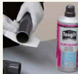
4. Reinigen von Rohr und Fitting mit dem Tangit PE/PP Reiniger auf Ethanolbasis
