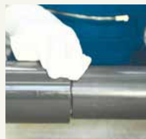
12. Rohr und Fitting sofort ohne Verdrehen bzw. Verkanten bis zur vollen Fittingtiefe zusammenschieben. Überschüssigen Klebstoff mit Fließpapier entfernen.
