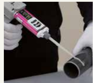
8. Klebstoff auf der Rohraußenseite auftragen.
