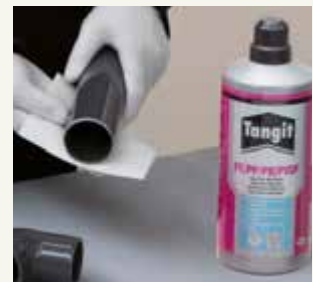
4. Reinigen von Rohr und Fitting mit dem Tangit PE/PP Reiniger auf Ethanolbasis
