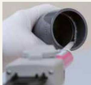
6. Klebstoff auf der Fittinginnenseite auftragen.
