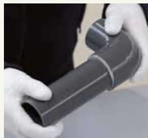
10. Rohr und Fitting sofort ohne Verdrehen bzw. Verkanten bis zur vollen Fittingtiefe zusammenschieben.
