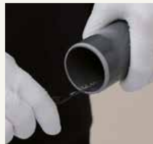
3. Rohrenden entgraten. Benutzen Sie einen Entgrater oder eine Feile.
