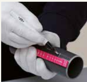
5. Die volle Rohreinstecktiefe ausmessen und das Maß auf dem Rohrende markieren.
